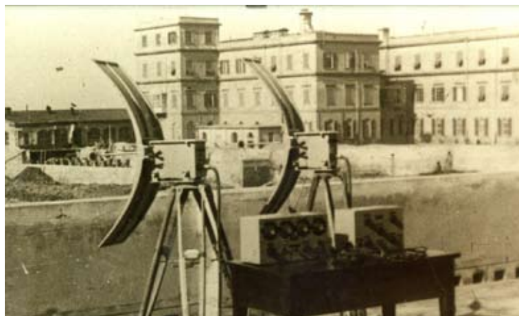
Figura 6. Radar EC1 in prova sulla terrazza dell'Istituto nel 1935
